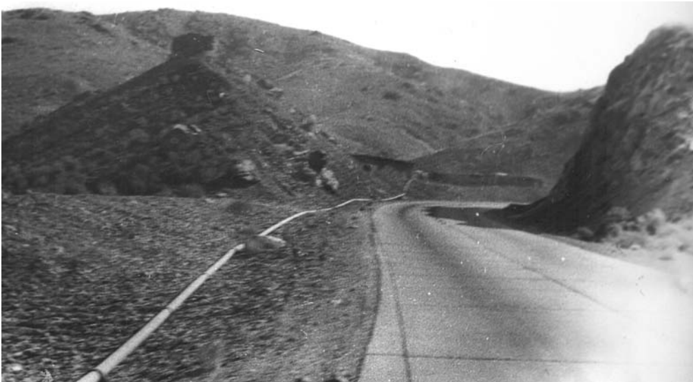
Трубопровод вдоль бетонки
